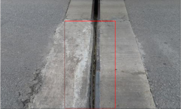
e) 设计选型、施工因素桥墩处伸缩装置缝宽异常，止水带拉断
