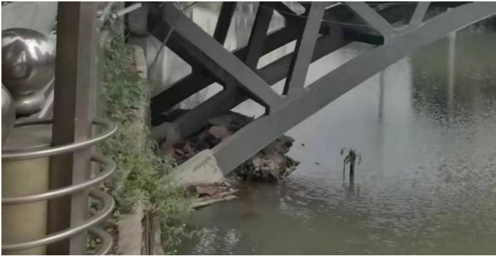
图 6-7 类似桥梁拱脚加固完成后照片
