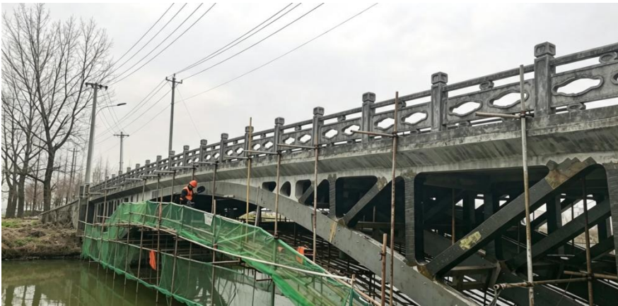
图 9-1 类似项目水上支架施工照片
