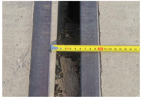
h) 泄水孔阻塞、雨水篦缺失
