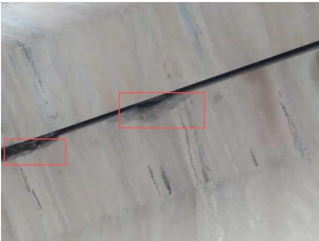
c) 端横梁底部存在露筋锈蚀病害
