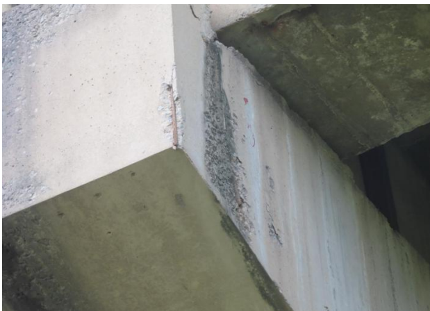
c) 桥墩立柱存在刮痕病害
