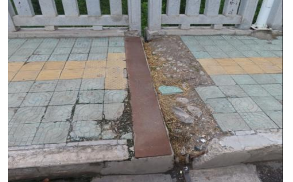
f) 设计选型、施工因素桥墩处伸缩装置缝宽异常，止水带拉断
