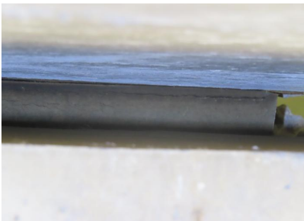
e) 橡胶支座存在开裂病害
