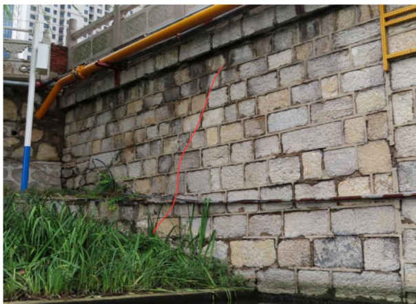
图 4-5 拱辰桥下部结构典型病害照片
