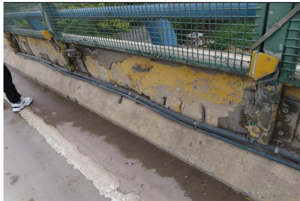
图 4-3 外环南路上跨立交桥桥面系及附属结构病害现场照片
