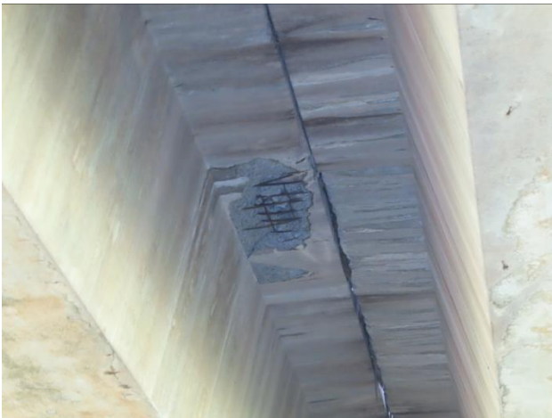
d) 湿接缝存在露筋锈蚀病害
