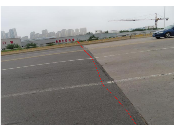
d) 桥头搭板与道路铺装连接处存在横缝病害
