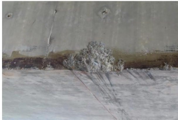
c) 橡胶支座存在开裂病害
