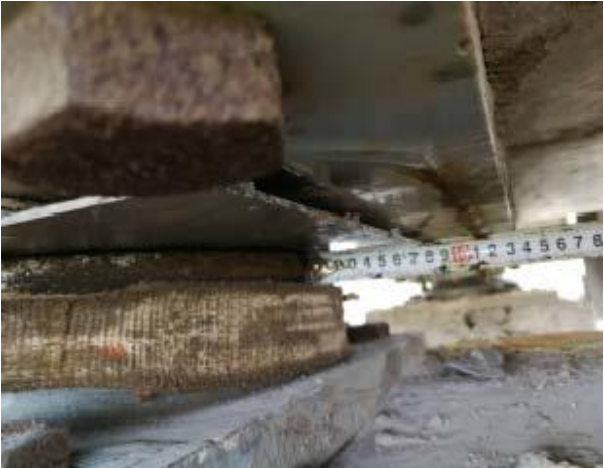
图 7-5 推移面安装
