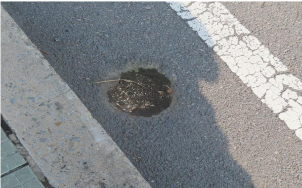
g) 泄水孔阻塞、雨水篦缺失
