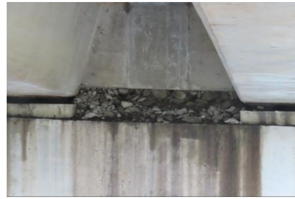
d) 18#台两侧锥坡轻微破损
