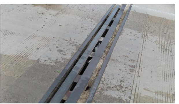
g) 分幅线处伸缩装置钢材料存在残缺病害
