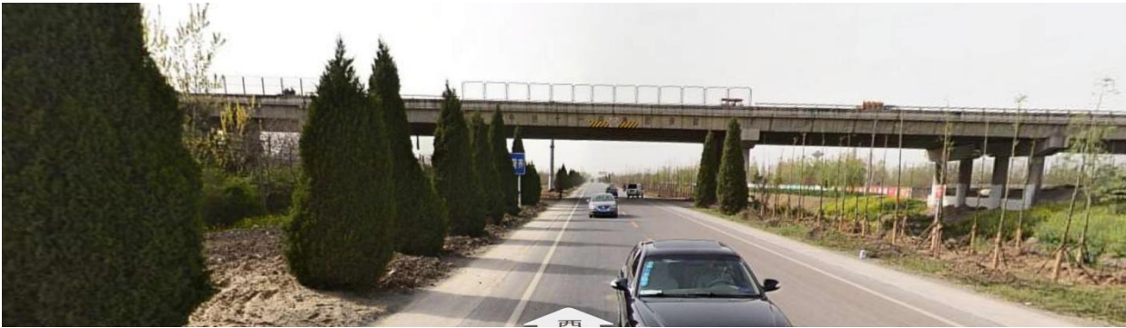
图 1-8 港口南路立交现场照片
