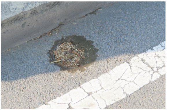
h) 泄水孔阻塞、雨水篦缺失
