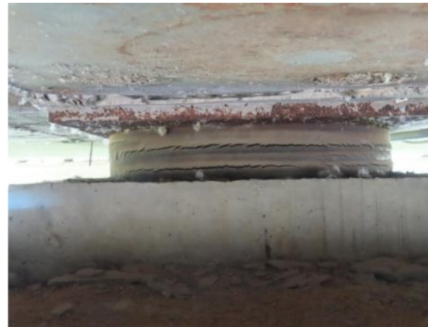
d) 橡胶支座存在开裂病害
