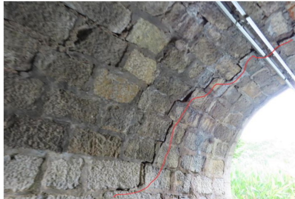
图 4-4 拱辰桥上部结构典型病害照片
