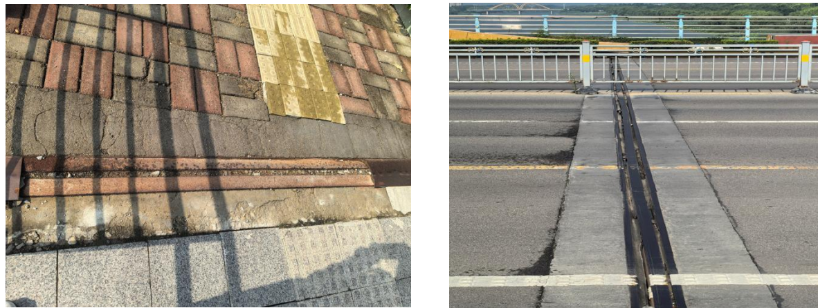
图 4-26 伸缩装置现场照片
