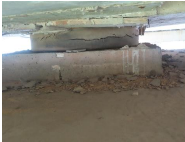
c) 橡胶支座存在开裂病害
