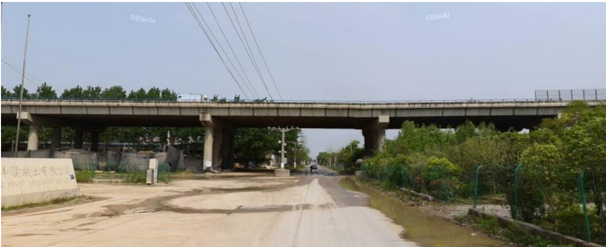
图 1-9 金海六路立交现场照片
