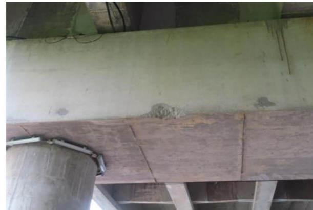
d) 橡胶支座存在开裂病害
