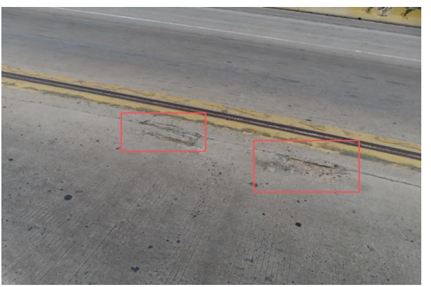
d) 桥头搭板与道路铺装连接处存在横缝病害
