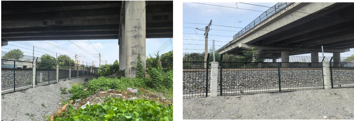
图 6-1 京沪双线铁路与桥墩位置照片
