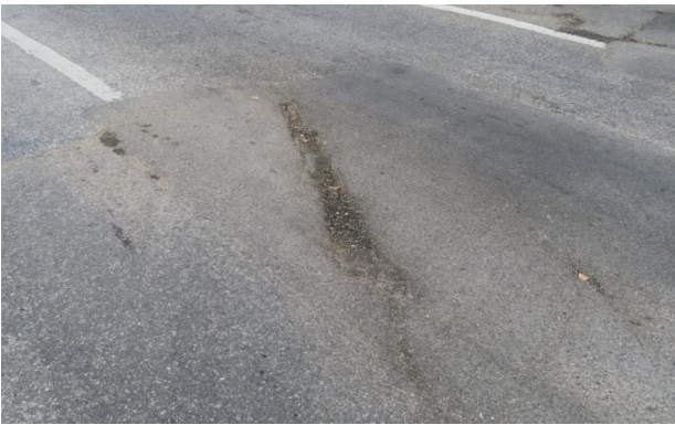
c) 6#墩伸缩装置型钢距人行道边缘 6m 处变形
