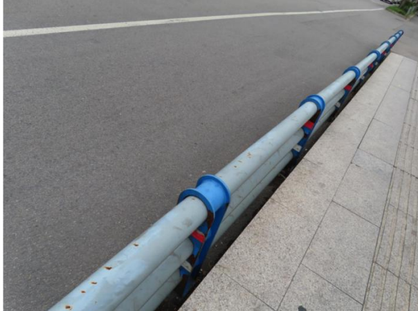
c) 钢护栏局部锈蚀
