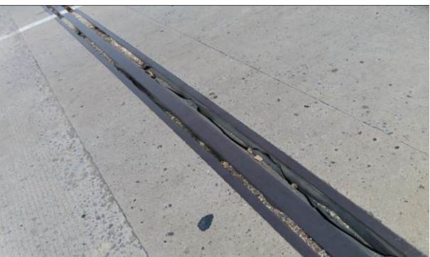
h) 伸缩装置钢材料存在翘曲变形病害
