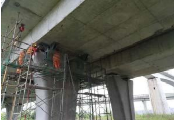
图 7-7 反力架安装
