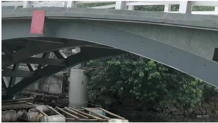
图 6-5 类似桥梁拱肋加固完成后照片
