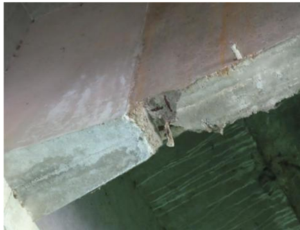
图 4-10 汴河大桥上部结构病害现场照片
