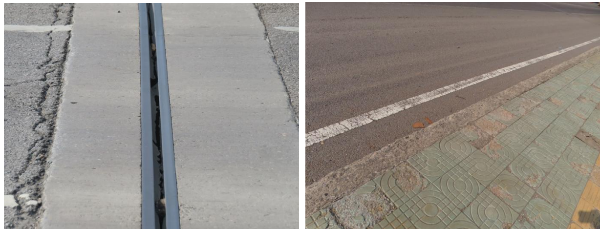
图 4-29 桥面系部分附属设施现场照片
